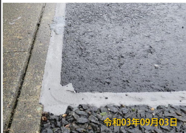
補修境界部目地硬化剤
