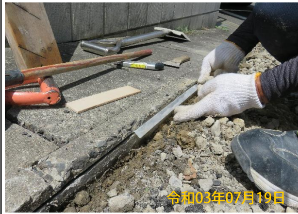
アスファルト部補修・防草フィルム設置
